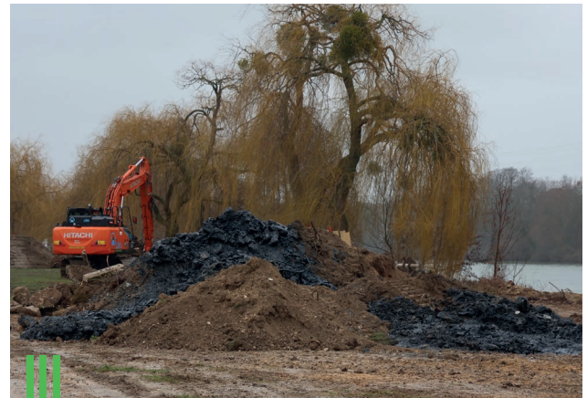
Extraction de terres de remblais et d'hydrocarbures lors des travaux, place des Fêtes, le 7 février 2024.
