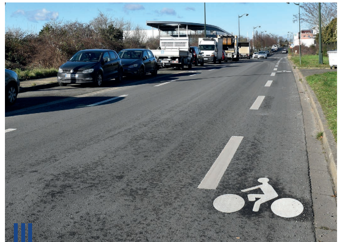
Nouvelle voie cyclable, avenue Eiffel
