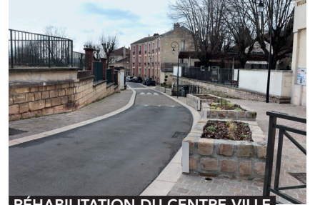
RÉHABILITATION DU CENTRE-VILLE FIN DES TRAVAUX RUE VICTOR-HUGO
